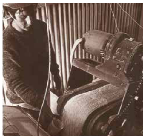
1974年 屋根材表面の石粒用粉砕機
